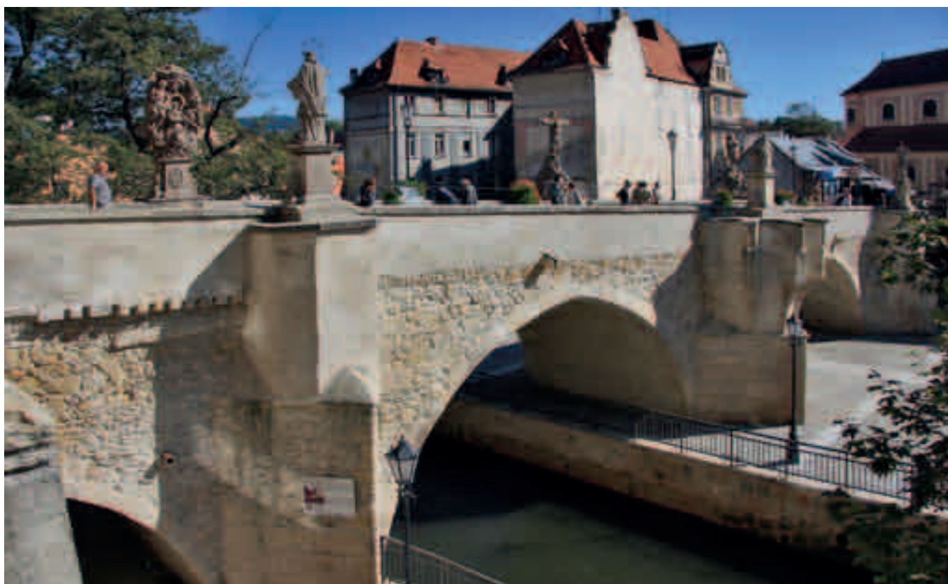
Kłodzko. Gotycki most nad Młynówką z około 1390 roku Glatz. Die Brücke über den Mühlgraben, etwa 1390
