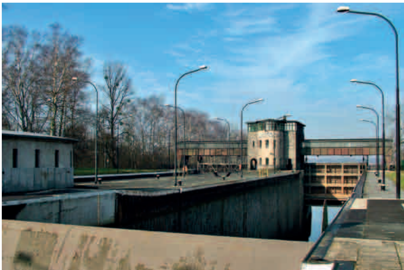
Pyskowice. Największa śluza na Kanale Gliwickim, ukończona w 1936 roku Peiskretscham. Die größte Schleuse auf dem Gleiwitzer Kanal, sie wurde 1936 fertig gestellt
