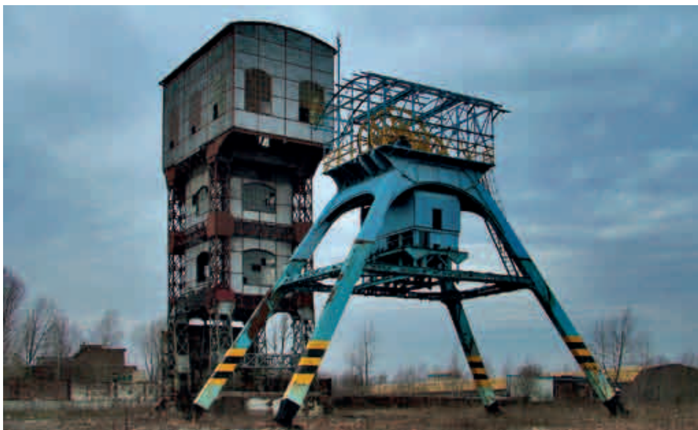
Świętochłowice. Pozostałości kopalni założonej w 1872 roku Schwientochlowitz. Überreste eines Bergwerks, das 1872 angelegt wurde
