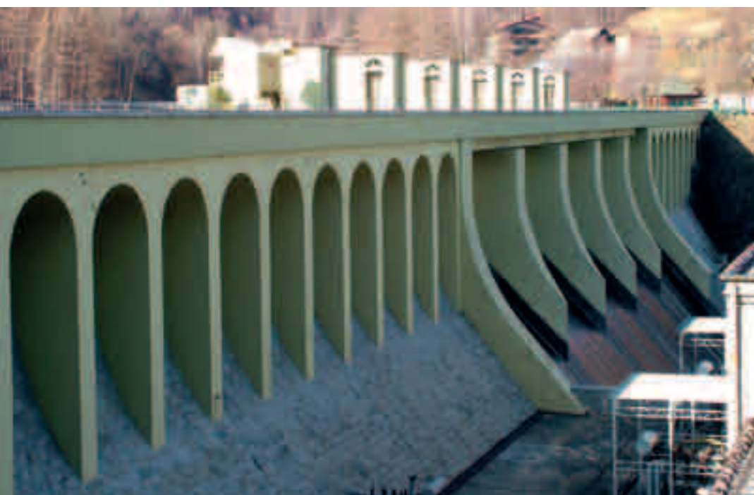
Porąbka. Zapora na Sole zbudowana w latach 1923–37 Porąbka. Der Staudamm auf dem Fluss Sola, erbaut in den Jahren 1923–37
