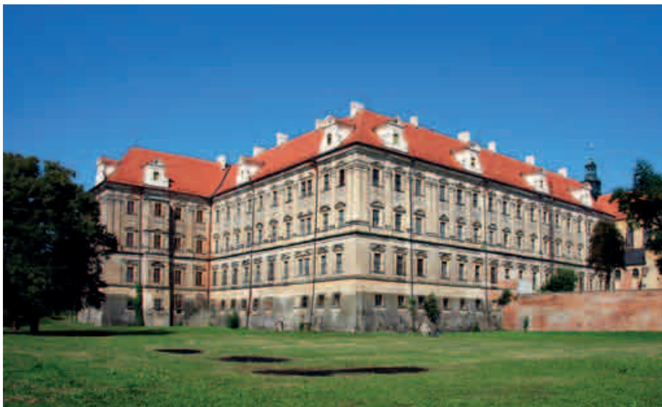
Lubiż. Zespół opactwa cystersów od strony południowo-wschodniej Leubus. Die Anlage der Zisterzienserabtei von der süd-östlichen Seite
